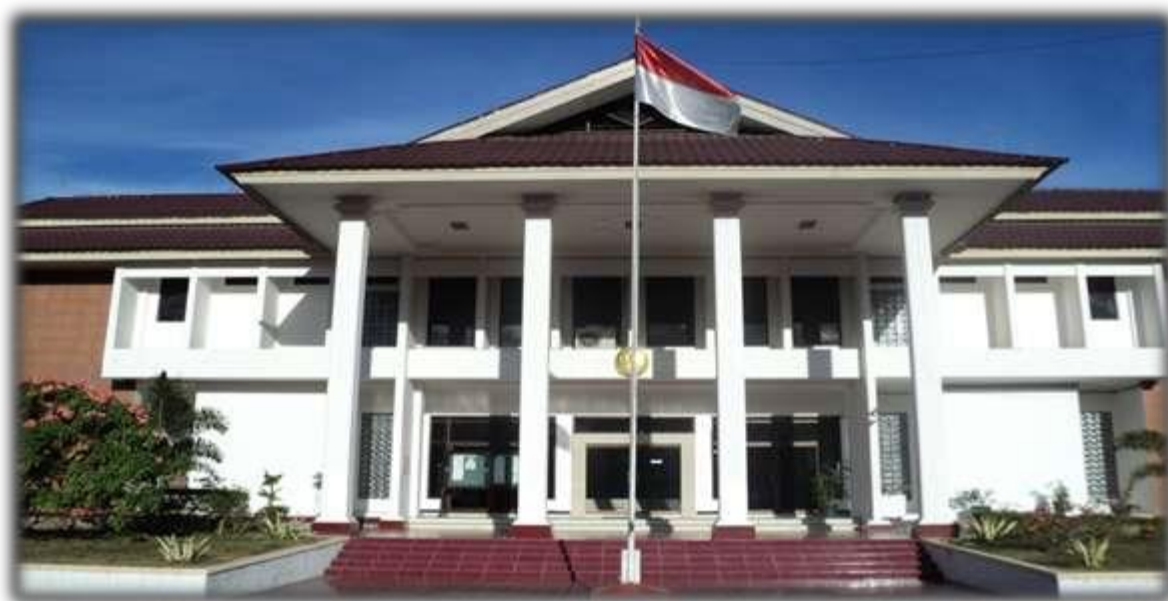
Gambar 2 (Gedung Pengadilan Tinggi Sulawesi Tengah Jalan Prof Muh Yamin No.1 Palu)
